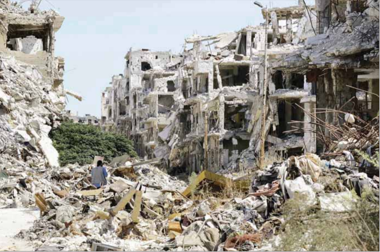
صورة تظهر الدمار الهائل في حي جورة الشياخ في حمص
